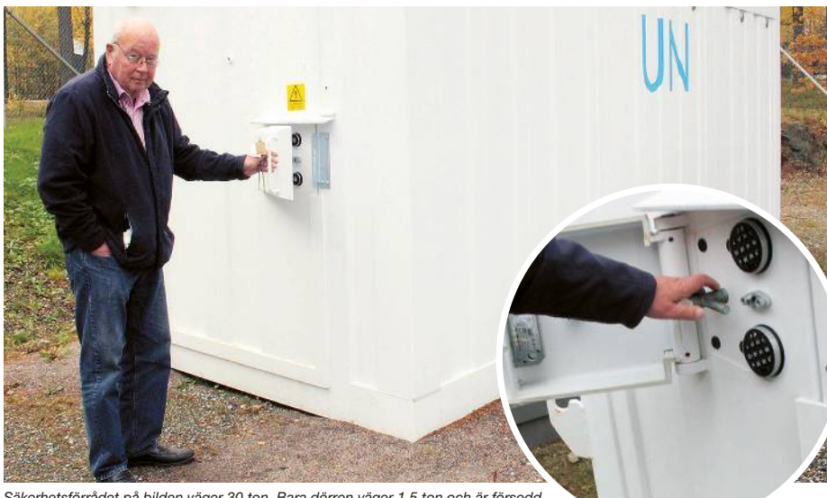
Säkerhetsförrådet på bilden väger 30 ton. Bara dörren väger 1.5 ton och är försedd
