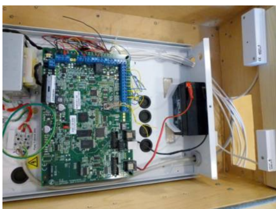
TEKNISKT. All kabeldragning och inkoppling nästan klart.
