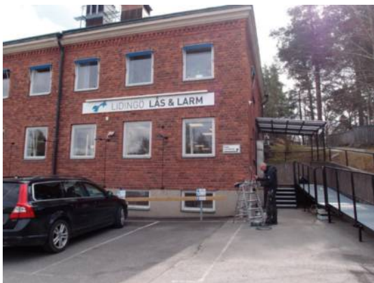
KUNDVÄNLIGT. Parkering och ramp gör besöket enkelt. Ny fasadbelysning är här under installation.
